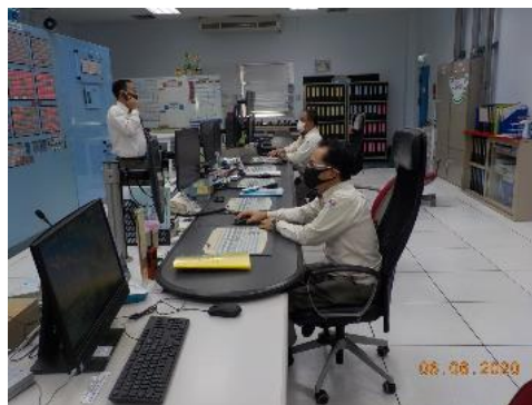
ภาพถ่ายที่ 2.2-37 ระบบควบคุมการทำงานด้วย DCS
