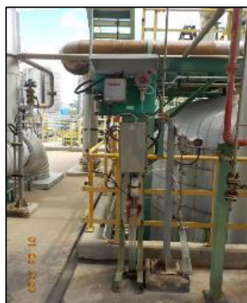
ภาพถ่ายที่ 2.2-14 HE Analyzer เพื่อตรวจสอบ Heptane ขาเข้า HE Detector
