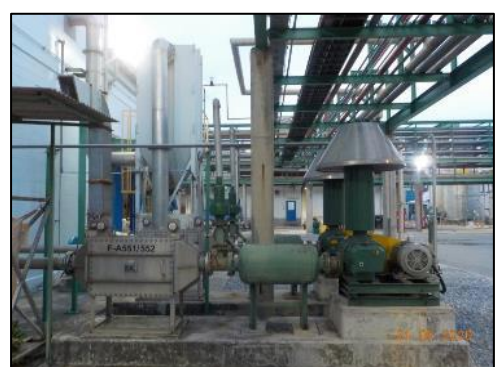
ภาพถ่ายที่ 2.2-23 อุปกรณ์ลดความดังของเสียง Silencer
